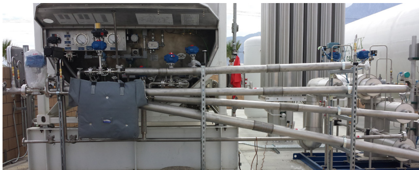
LNG Vacuum Insulated Lines
